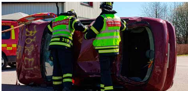
FÖRST KONTROLLERAR brandmännen den skadade och skyddar denne för glassplitter när dom klipper taket.
